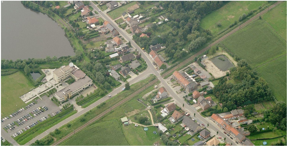
Eigenlotunnel (vanuit oosten)
