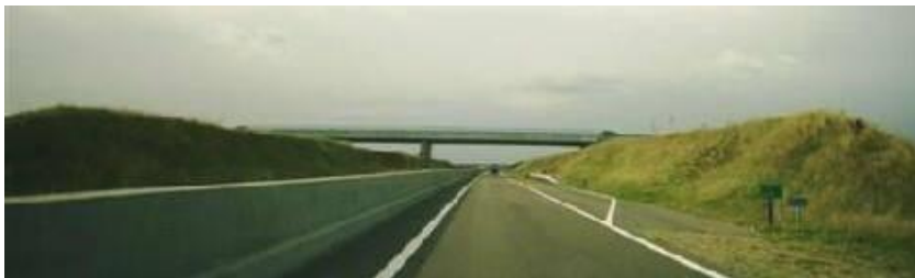
Figuur 15: referentiefoto groene talud
