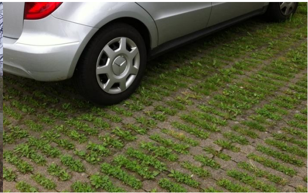
Voorbeeld van waterdoorlatend materiaal
