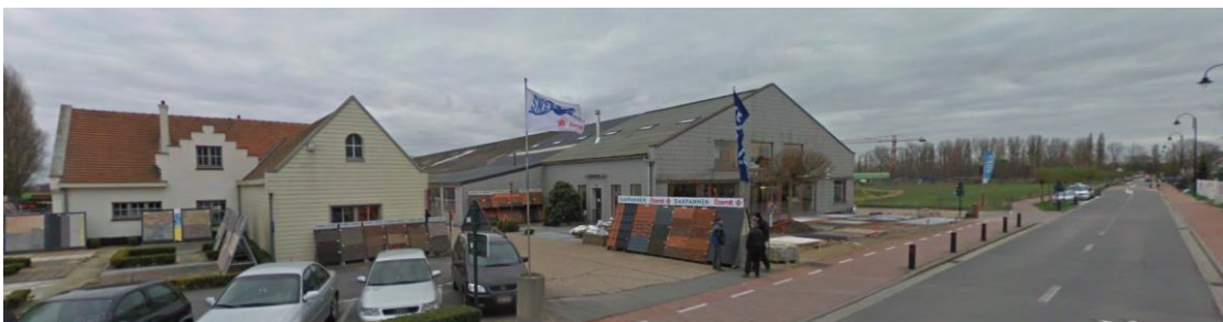
Figuur 12: zicht op de gebouwen langs de Kragendijk
