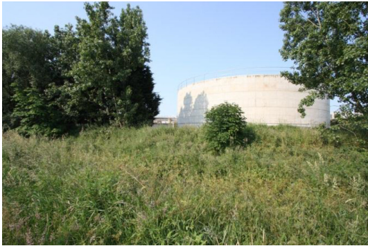
Foto 5 - zicht op de achterkant van de waterzuiveringsinstallatie gezien vanaf het jaagpad.
