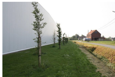
Foto 2 – Zicht op buffer tussen de Peperstraat en de conditioneringsloodsen
