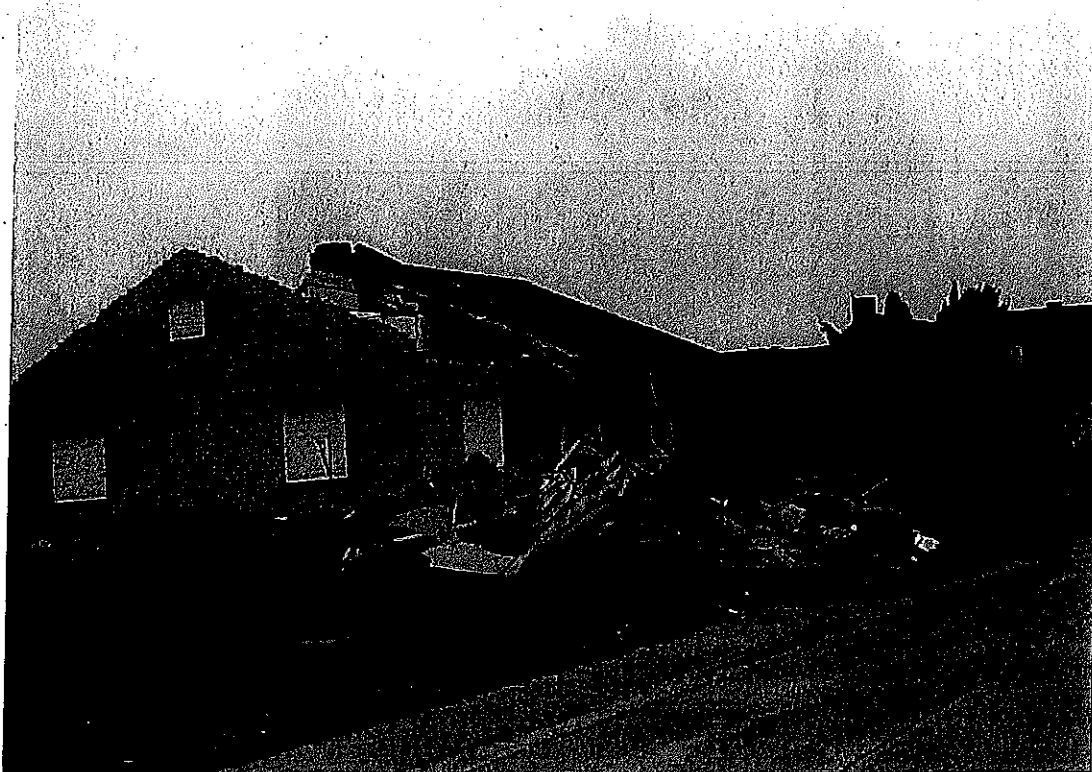
Foto 9: Afgerukt dak – IJzerenkruisstraat 27– Zepperen.
