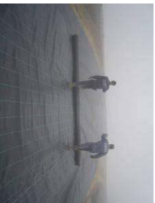
Aanbreng van geotextiel op een werfweg met daarbovenop een laag COPRO-gekeurd breekpuin
