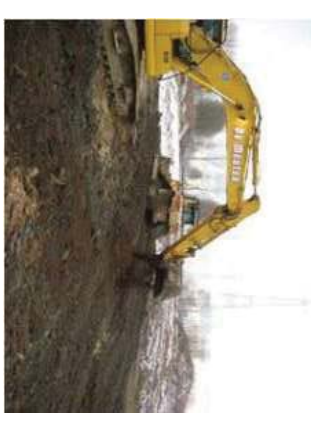
Aanvoer van grond op vaste afkippunten en openspreiden met kranen op rupsbanden
