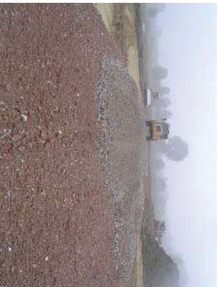
Aanbreng van geotextiel op een werfweg met daarbovenop een laag COPRO-gekeurd breekpuin
