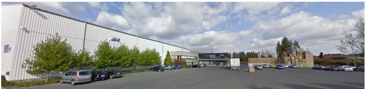
Figuur 12: parking en hoofdtoegang van het bedrijf
