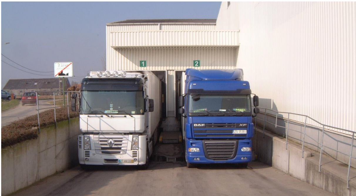
Figuur 13: de loskade, palend aan de hoofdtoegang en links de Peperstraat
