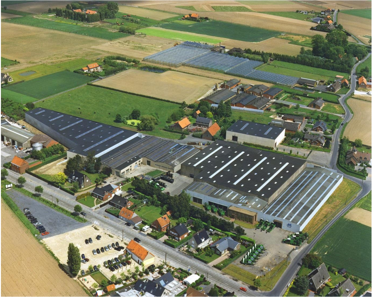
Figuur 10: zicht vanuit het oosten op de huidige bedrijfsite en omgeving
