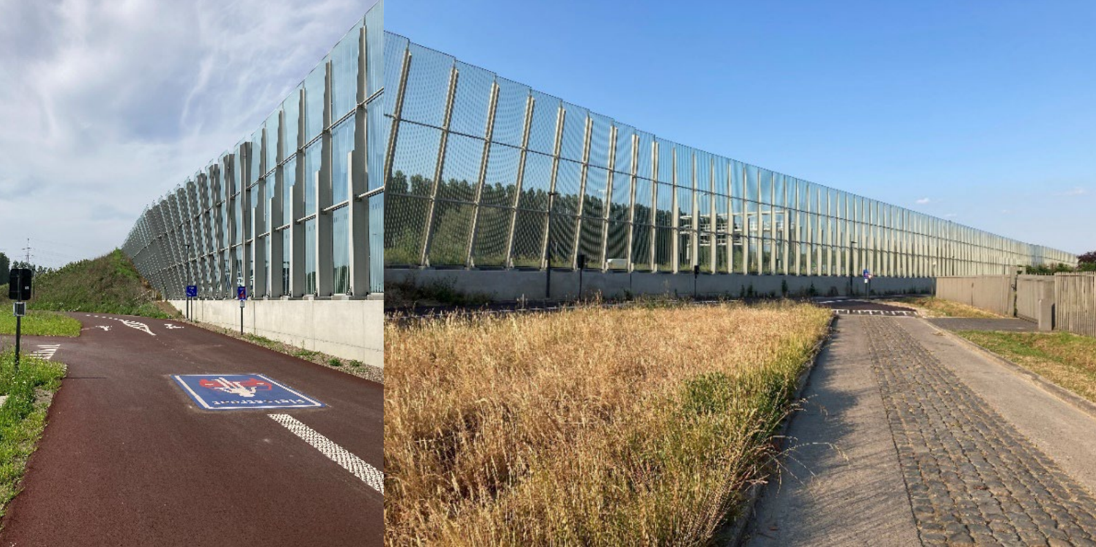
Figuur 5 - Glazen geluidsscherm zoals in Ringpark West, langs de fietsostrate aan de Neerstraat in Zwijndrecht (© Stad Antwerpen).
