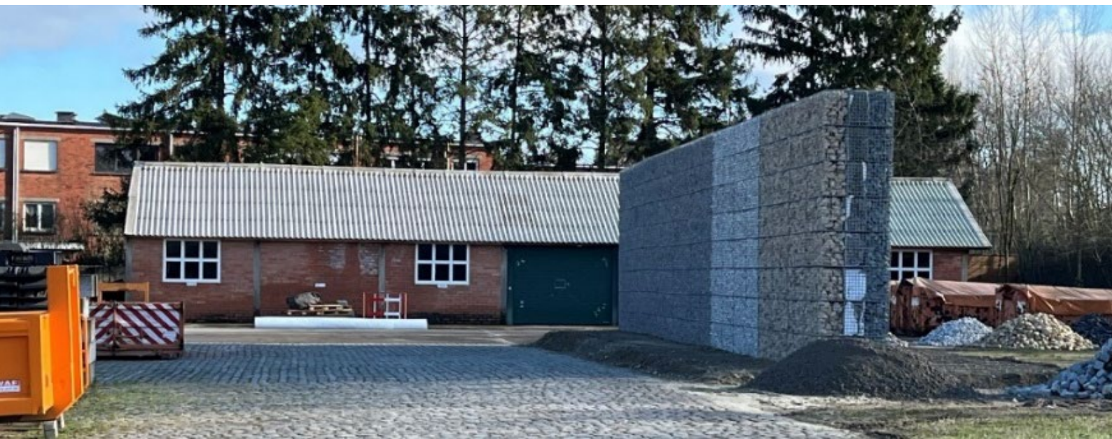
Figuur 1 - Proefopstelling van geluidswerende wanden voor het Pomppark Zuid in 2024 (© AG Vespa).
